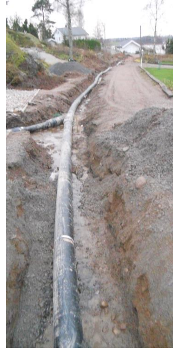
Schakt i väggkant (Ostkusten)
