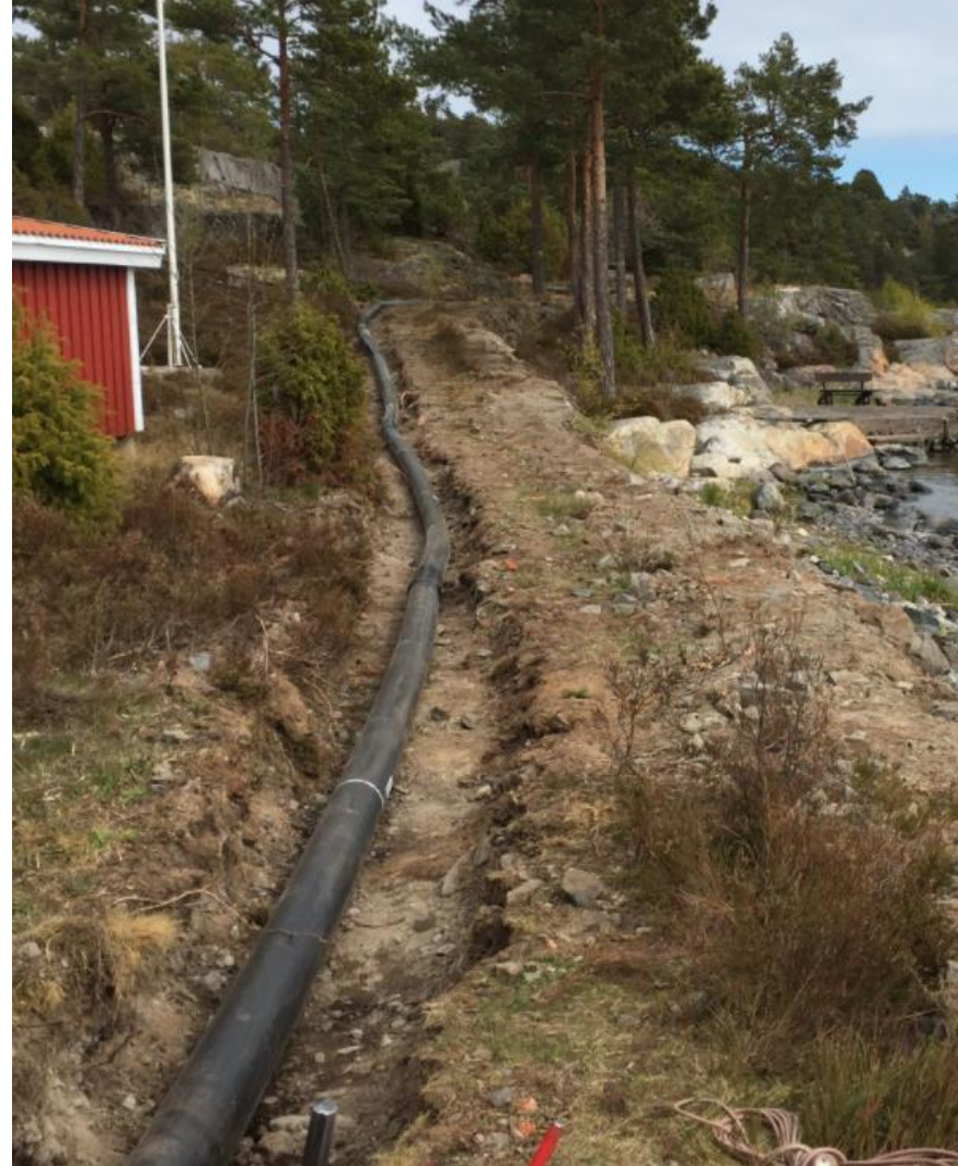
Grunt schakt (Ostkusten)
