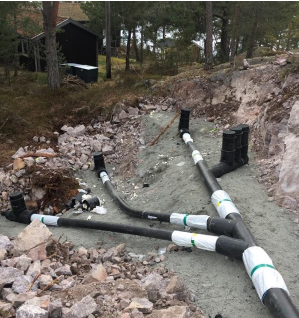
Tre servisventiler och en dubbel-spolpost monterade, färdiga för muffning (Ostkusten)
