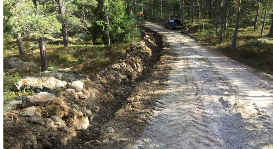
Fint schakt på Hornslandet
