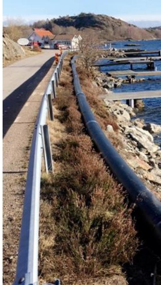
Ledning utefter väg, övertäckt med maka- dam (Västkusten)
