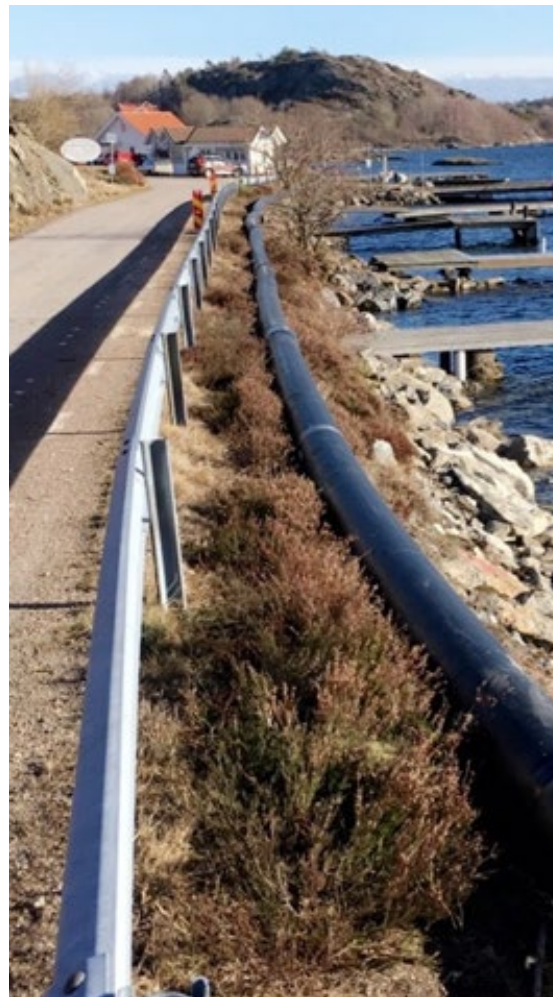
Ledning utefter väg, övertäckt med maka- dam (Västkusten)
