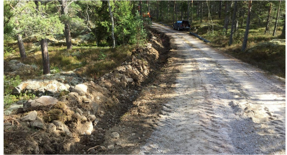
Fint schakt på Hornslandet
