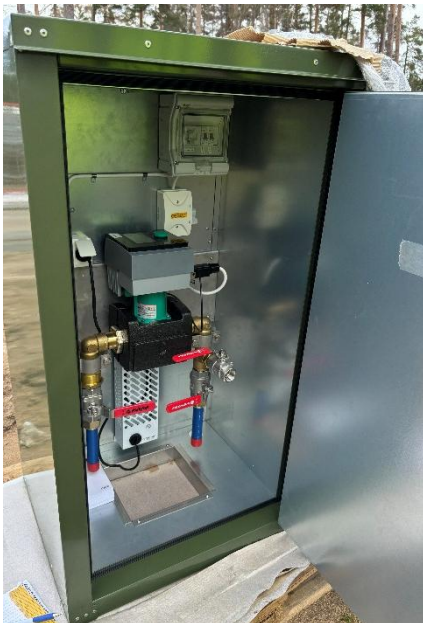
Skåp med cirkulationspump
